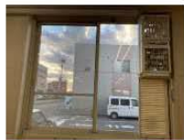
患者待合室の換気促進のため、導め込み式の簡易型吸排気換気扇を設置
